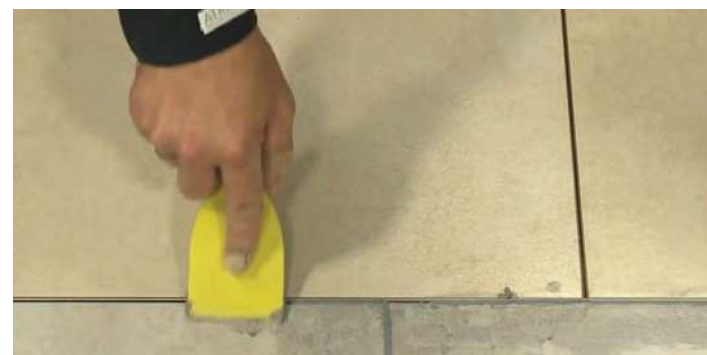
Foto 18: Aplicação do rejunte
