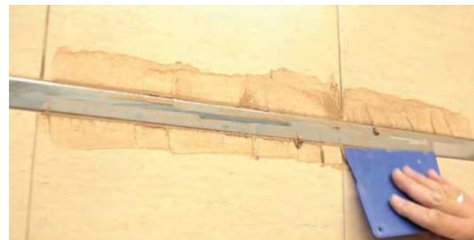
Foto 33: Aplicação do rejunte
