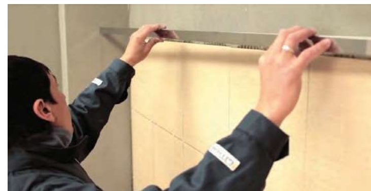
Foto 26: Posicionamento do listelo no local, sem argamassa colante para verificar a necessidade de cortes
