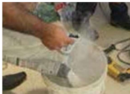
Foto 6: Preparo da argamassa colante | adição do pó.
