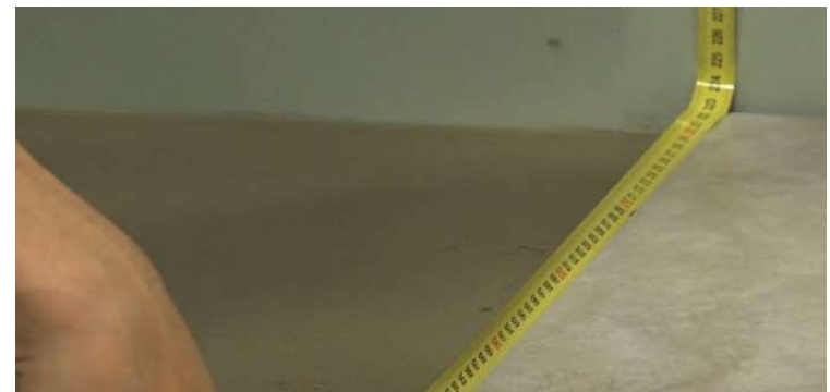
Foto 09: Medição do ambiente para realização do corte no filete metálico
