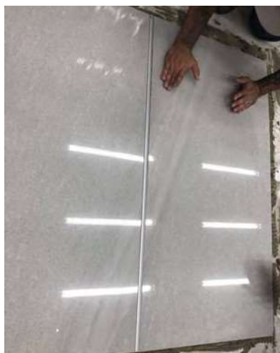
Foto 21: Assentar a próxima peça de revestimento
