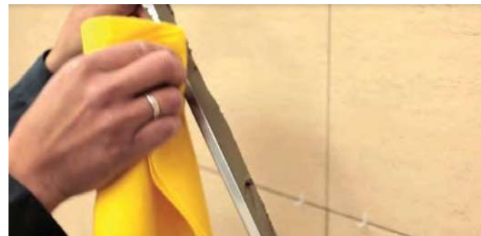
Foto 30: Limpeza da lateral para remover os excessos de argamassa colante
