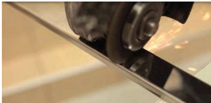
Foto 28: Corte do filete metálico com esmerilhadeira e disco para metal
