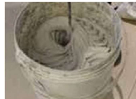
Foto 7: Mistura com haste helicoidal, formando uma pasta homogênea.
