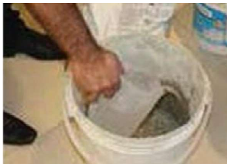
Foto 5: Preparo da argamassa colante | adição da água.
