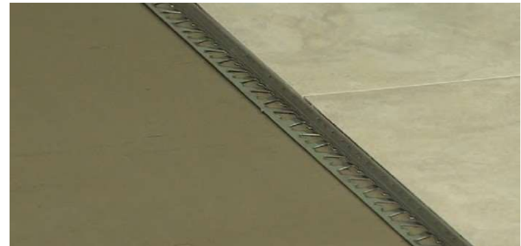
Foto 08: Posicionamento do perfil no local, sem argamassa colante para verificar a necessidade de cortes
