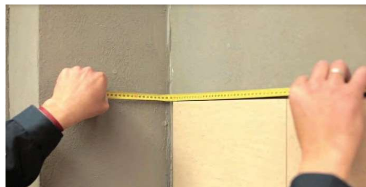
Foto 27: Medição do ambiente para realização do corte
