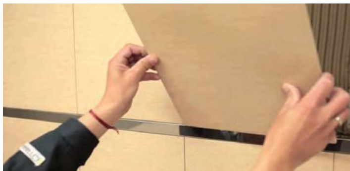
Foto 32: Aplicação do restante do revestimento
